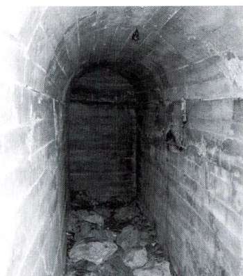
Lám. 22 c. Interior del refugio
