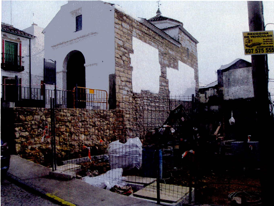
1.-Nuevo espacio ajardinado junto a Ermita. (En obras).
