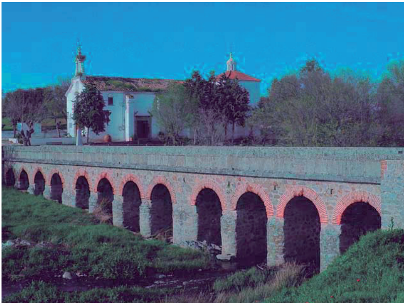
2. Vista general del puente.
