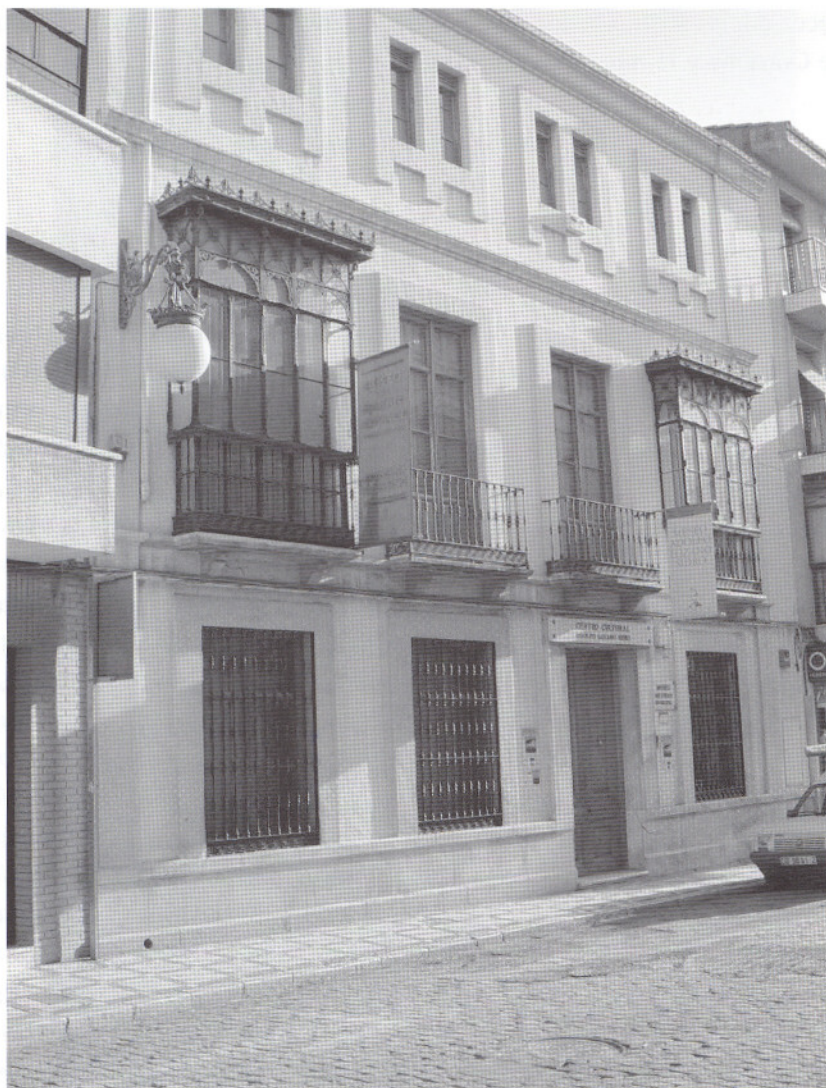
Casa donde falleció en Priego de Córdoba
