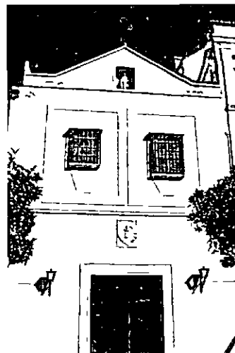
Fachada actual de la antigua iglesia conventual de Santa Teresa
