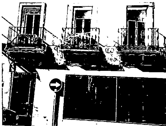
Fachada Casino aspecto actual
