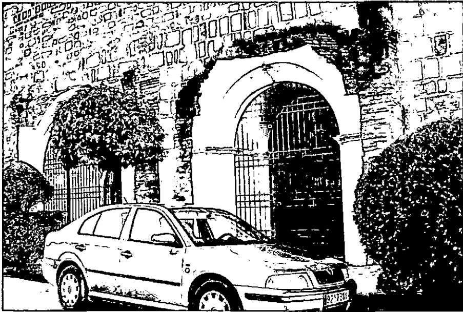
Arcos que daban acceso a las capillas de El Carmen y de las Benditas Ánimas
